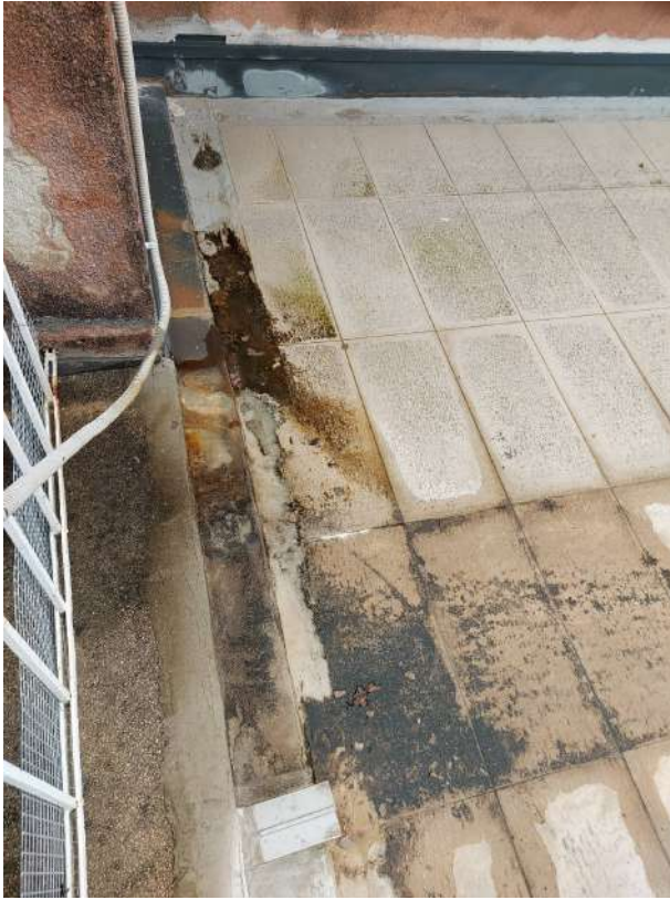
Slika 6: Spoj krova i zida terase s preljevom
