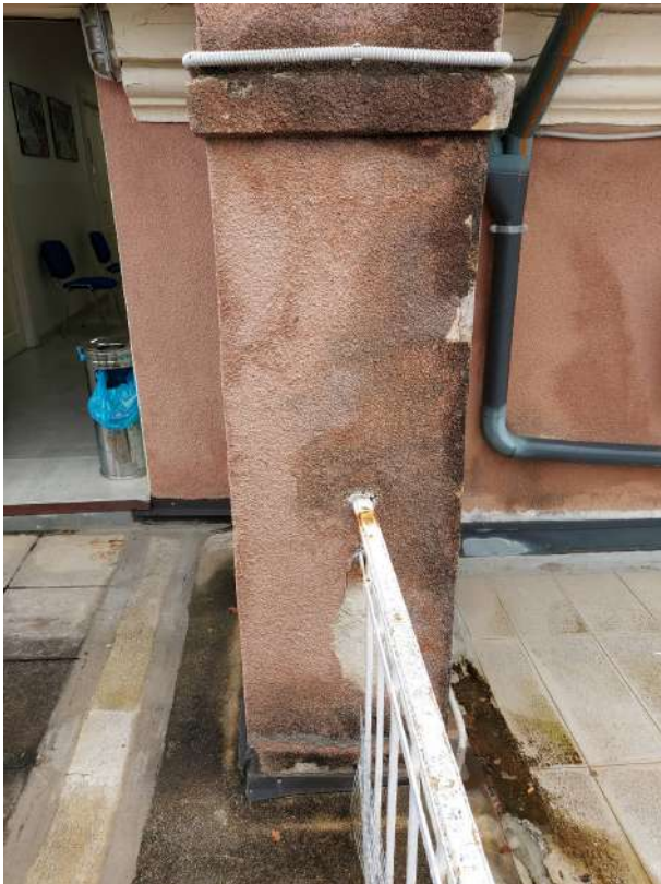
Slika 7: Ograda terase prema krovu
