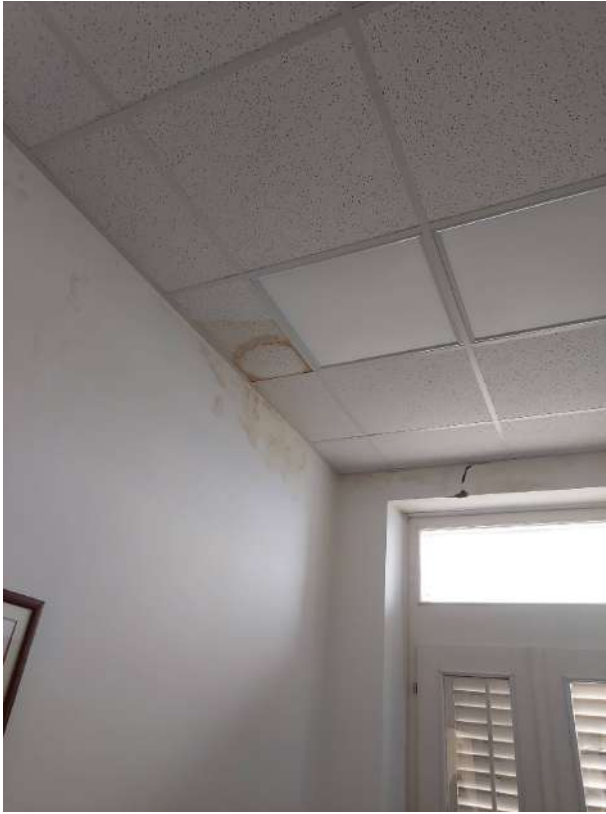
Slika 4: Strop u hodniku drugog kata
